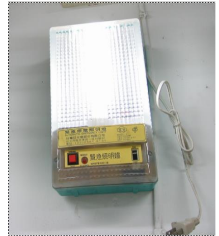
緊急照明設備 (定期測試)
